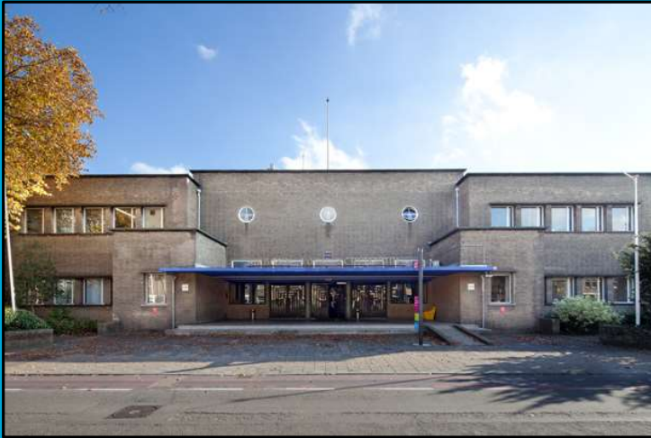
Gebouw voor Scheikunde Julianalaan 136
